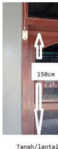
Gambar 3. Pemasangan bel rumah berjarak 150cm
